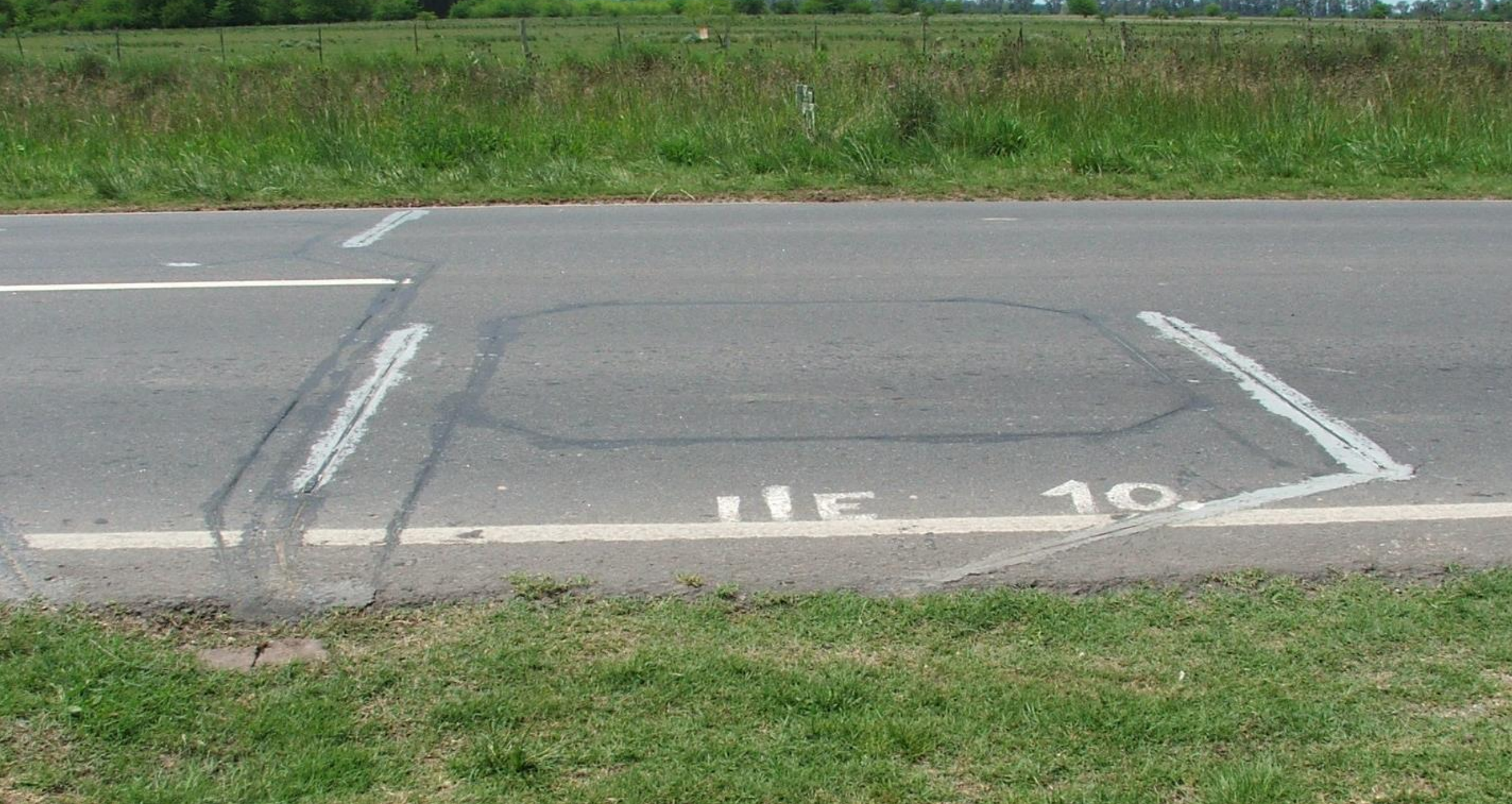
Contadores volumétricos y clasificadores de tránsito con lazos inductivos y barras piezoeléctricas
